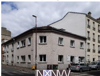
Ossature bois Remplissage chaux / chanvre
