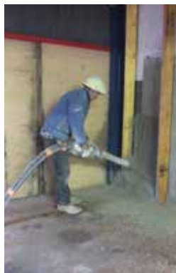
Projection de béton de chanvre
