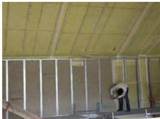
Pose de panneaux de laine de chanvre
